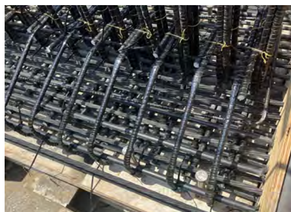
CFCC 緊張材使用橋桁 (GFRP スターラップの取付状況)
