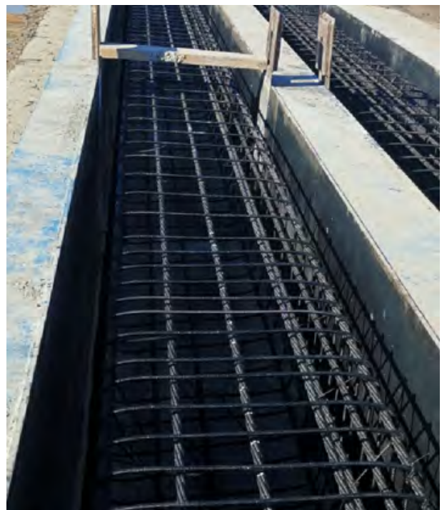
PC 緊張材(CFCC スターラップの取付状況)
