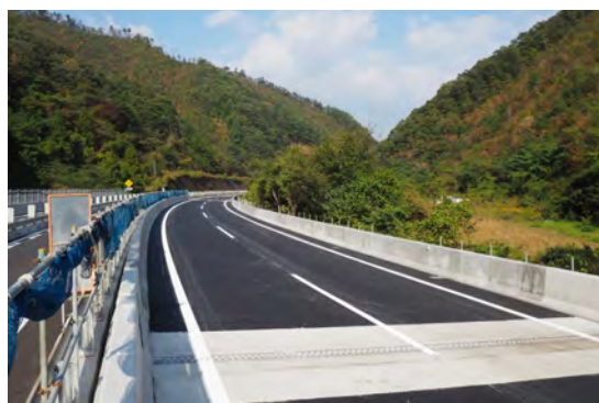
写真-1 中国自動車道 蓼野第二橋(下り線)
