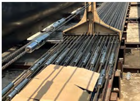
CFCC 緊張材の配置状況 (緊張後)
