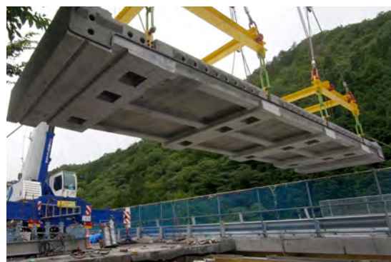
写真-2 超高耐久床版の架設状況
