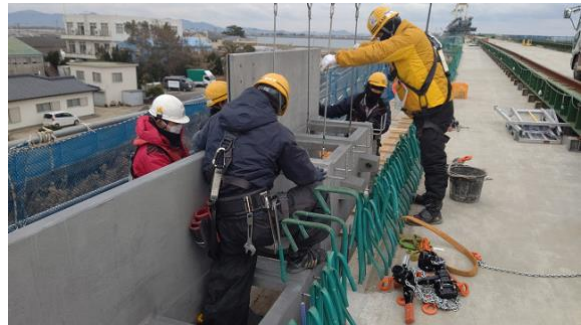
写真-3 排水溝設置状況
