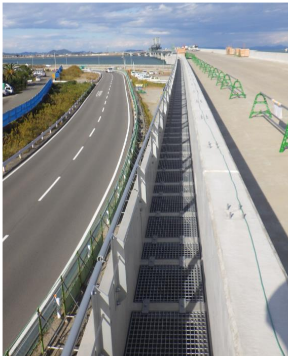
写真-4 設置後排水観
