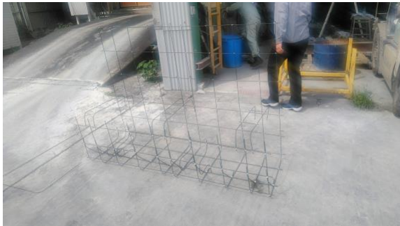
写真-1 組み立てたCFCC補強筋
