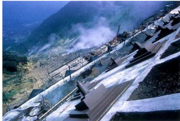
図-4 温泉土壌における軽量受圧版を用いたグラウンドアンカー
