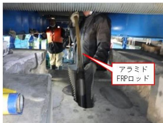
写真-2 アラミド FRP ロッド挿入状
