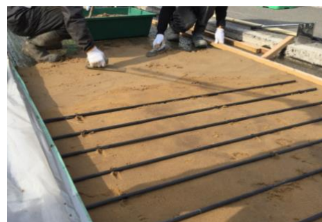
写真-2 CFRP ロッド設置後状況
