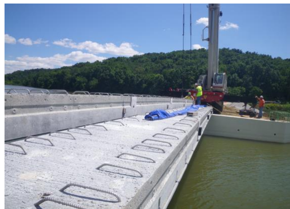
写真-2 現場でのボックスビーム桁の設置
