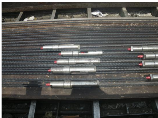
写真-1 定着金具の取り付け
