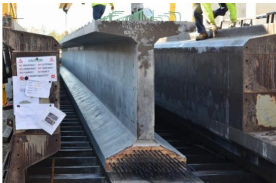
写真-1 桁完成
