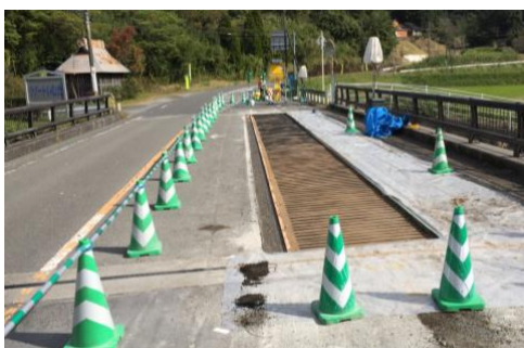
写真-1 CFRP ロッド設置状況
