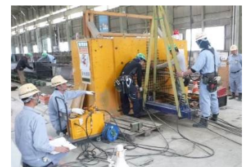
写真-2 PC ホロー桁製作状況
