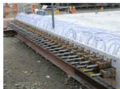
写真-3 ポストテンション緊張用端末 (グラウド強度発現後切断)
