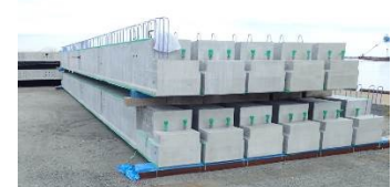
写真-3 PC ホロー桁仮置状況
