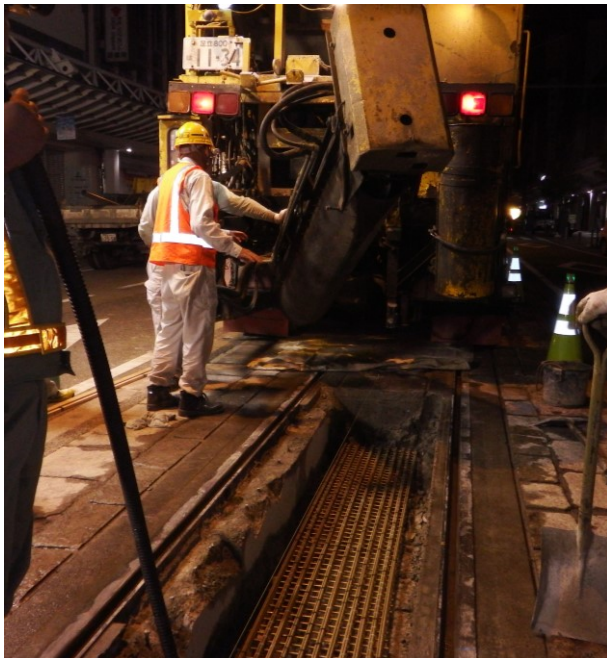
写真-1 ジェットコンクリート打設状況
