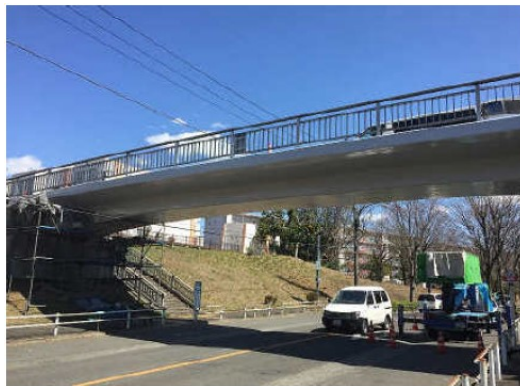
写真-1 落合第一歩道橋
