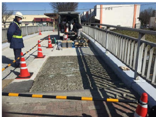
写真-2 施工状況(プライマー塗布)
