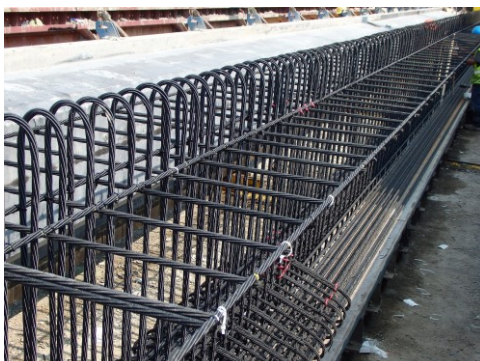
写真-2 CFCC 補強筋組立状況
