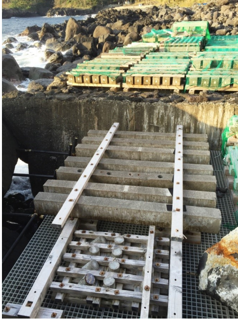
写真-1 飛沫帯の暴露状況
