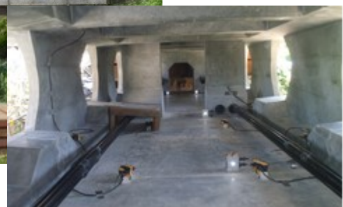
写真-2 アラミド FRP 外ケーブル
