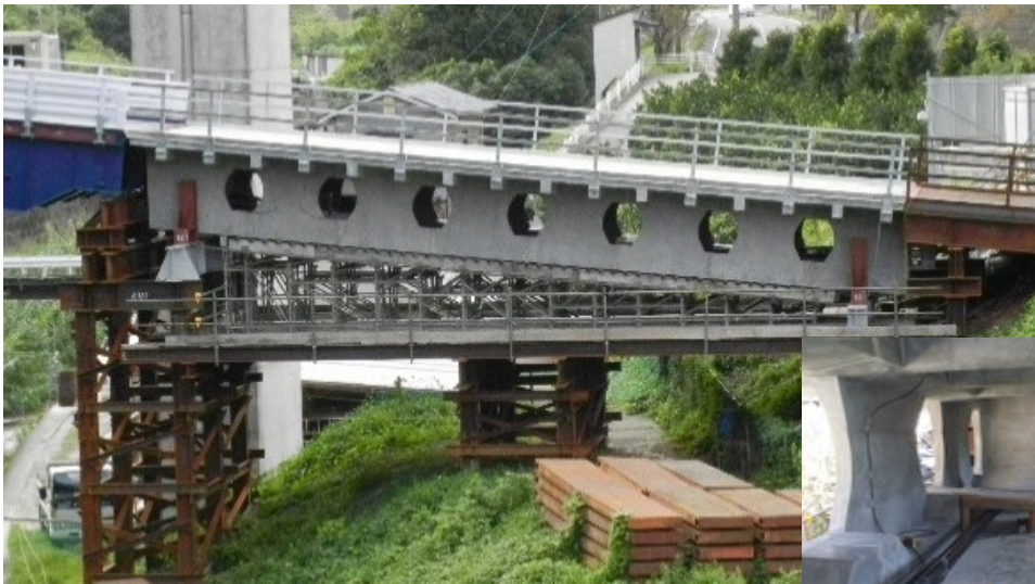
写真-1 Dura-Bridge 実証橋全景
