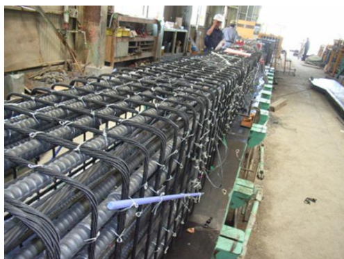
CFRP 補強筋組立
