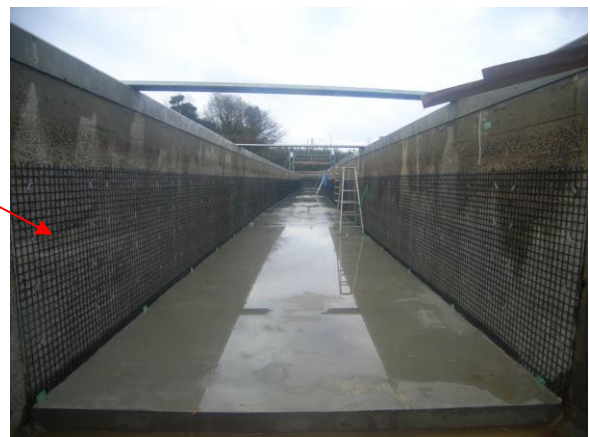
底版コンクリート打設後
