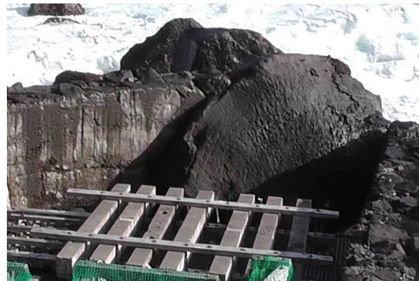
写真-2 海洋環境の暴露状況
