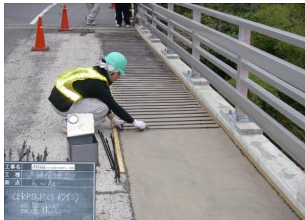
リードライン設置状況
