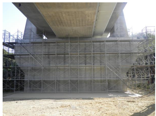
図-2 主塔の橋脚部の補強正面図と写真
