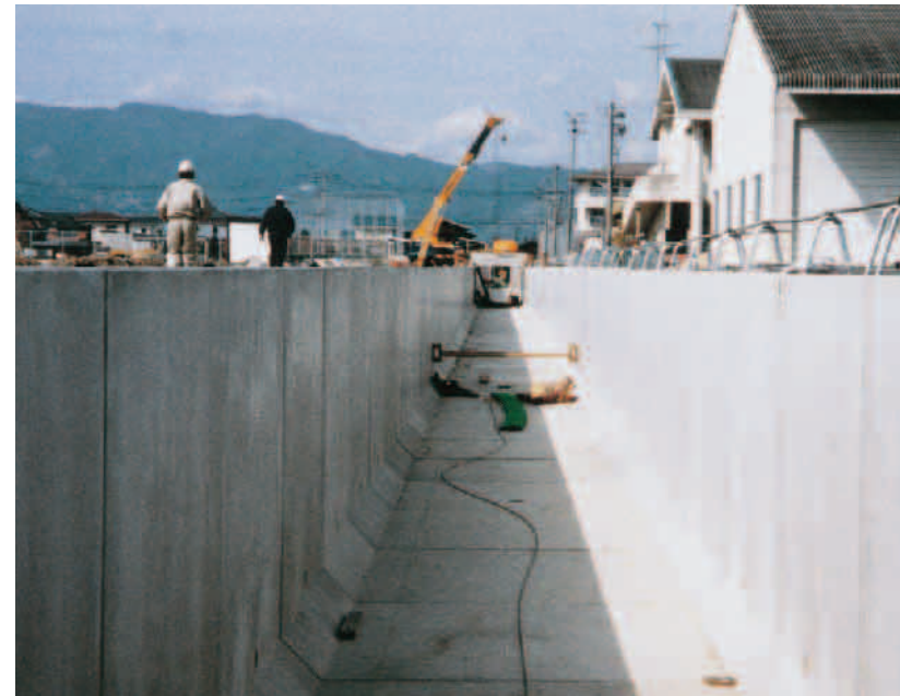
佐賀中部地区用水路工事、地盤沈下に対応 96~99
